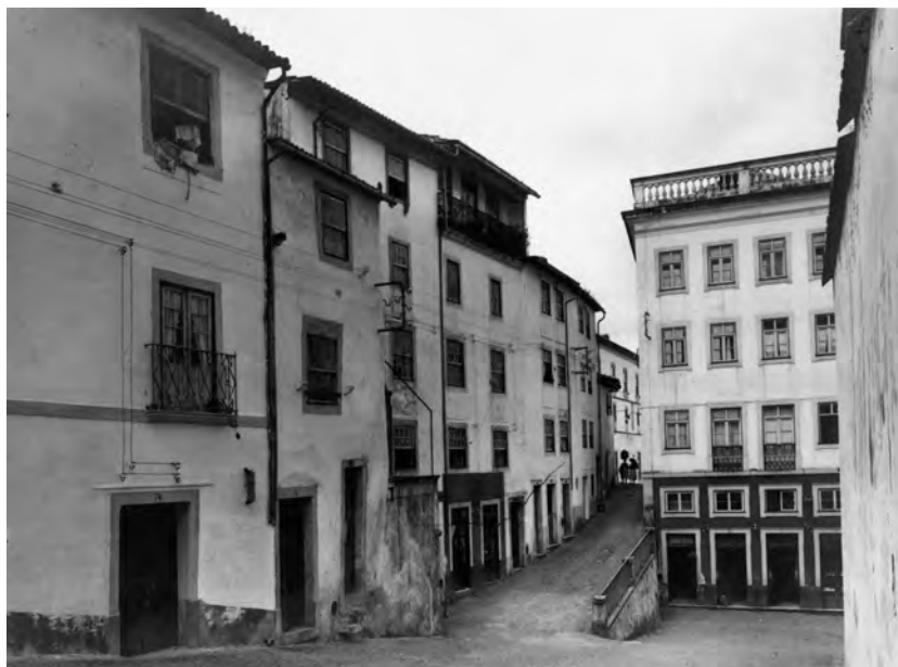
Fig. 2 – Edifícios demolidos (c. 1945) para construir a Cidade Universitária de Coimbra (Colecção do Núcleo de Arquivo Técnico de Construções Escolares, Ministério da Educação).
