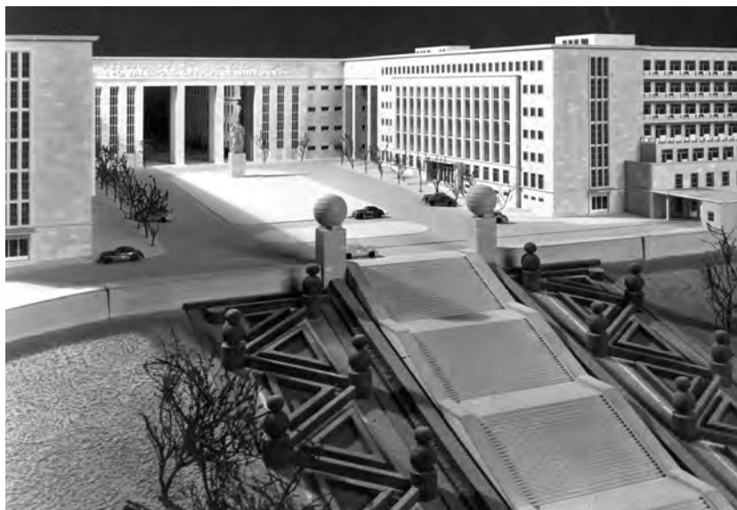
Fig. 3 – Maqueta da Cidade Universitária de Coimbra (Colecção do Núcleo de Arquivo Técnico de Construções Escolares, Ministério da Educação).
